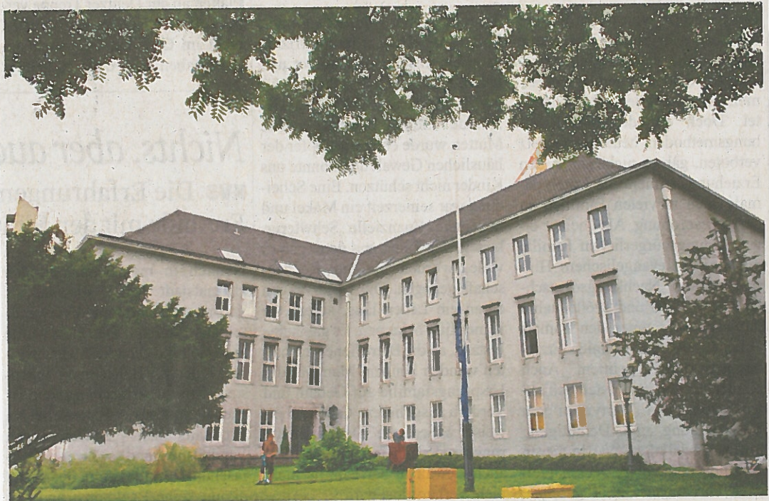
Der Bau der ehemaligen Sachtleben Aktiengesellschaft für Bergbau und chemische Industrie
