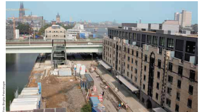
Mit Blick auf den Dom: Halle 11 und der Rohbau des Art'otels.
